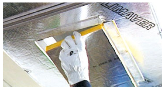
Le PERFIVER H permet la réalisation des registres nécessaires au nettoyage des conduits.
