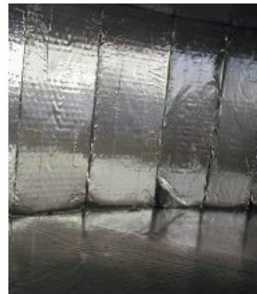
Méthode par recouvrement finition intérieure du conduit
