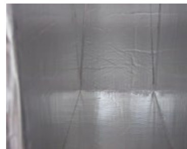
Méthode des Tronçons Droits finition intérieure du conduit
